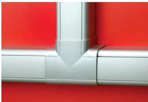
Затем крышки коробов сдвиньте в сторону тройника или переустановите их заново, чтобы они зашли под накладку.
