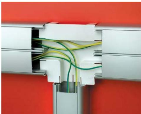
Защелкиванием установите крышки на основания коробов, отступив от края (торца) каждого короба по 3 см или более.
